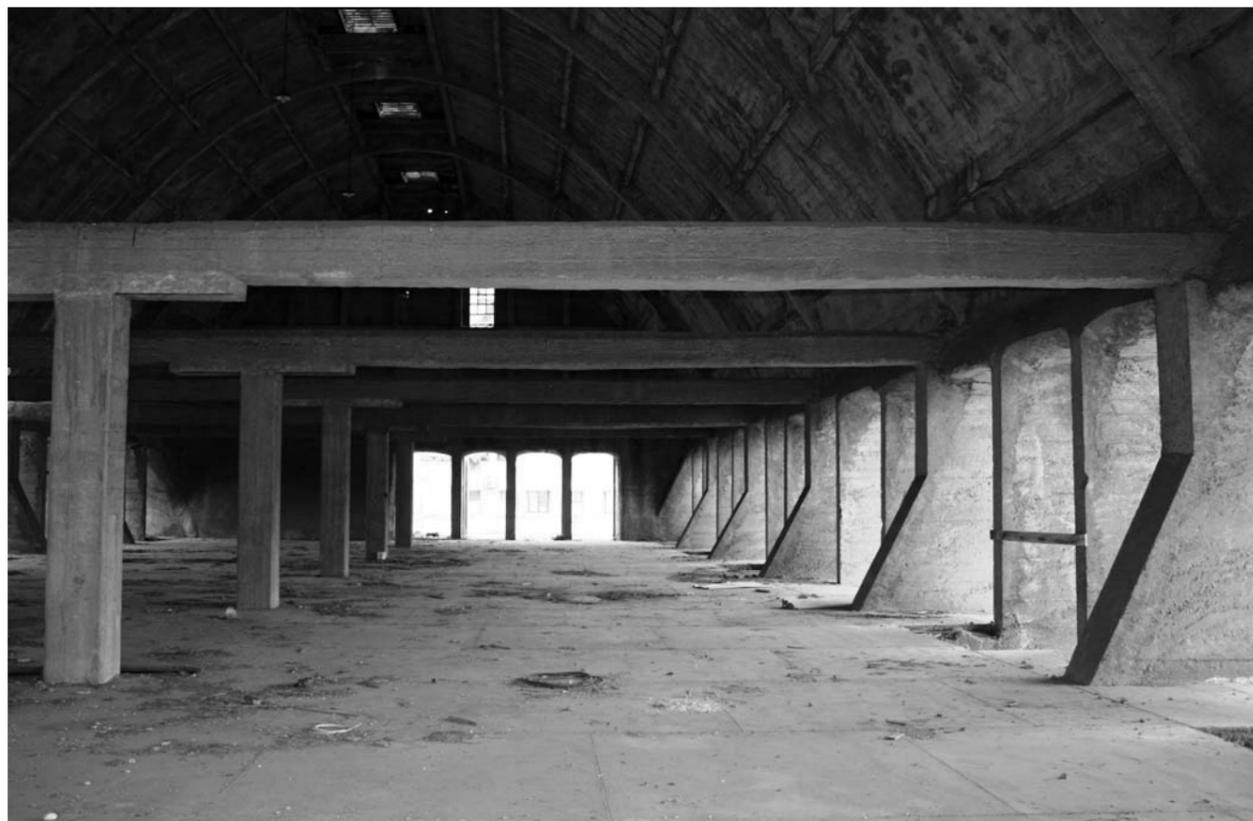
Figura 9. Valutazione strutturale della volta dell'ex-deposito di clinker di Casale e suo funzionamento senza tirante e pilastri intermedi, cfr. nota 6.
